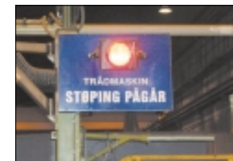
Lyssignal - støping pågår
