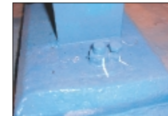
Visuell kontroll av bolter
