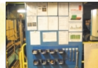
Reservedeler plassert hensiktsmessig i løskveilområdet
